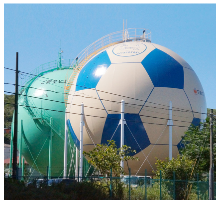
むららん おおさわ 室蘭ガス サッカーボールタンク※2 (室蘭市大沢町)
