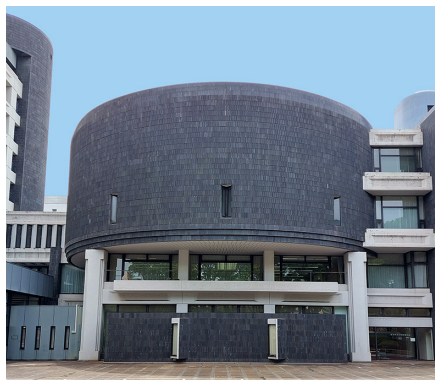
おおいた とう にあげ 大分市役所 議会棟 (大分市荷揚町)
